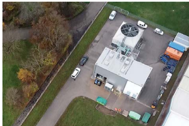
LUFTBILD DER ANLAGE BRUCHSAL
