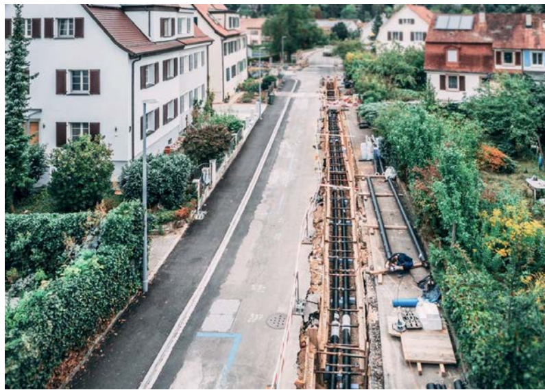
VERLEGUNG DER FERNWÄRMELEITUNG IN RIEHEN
