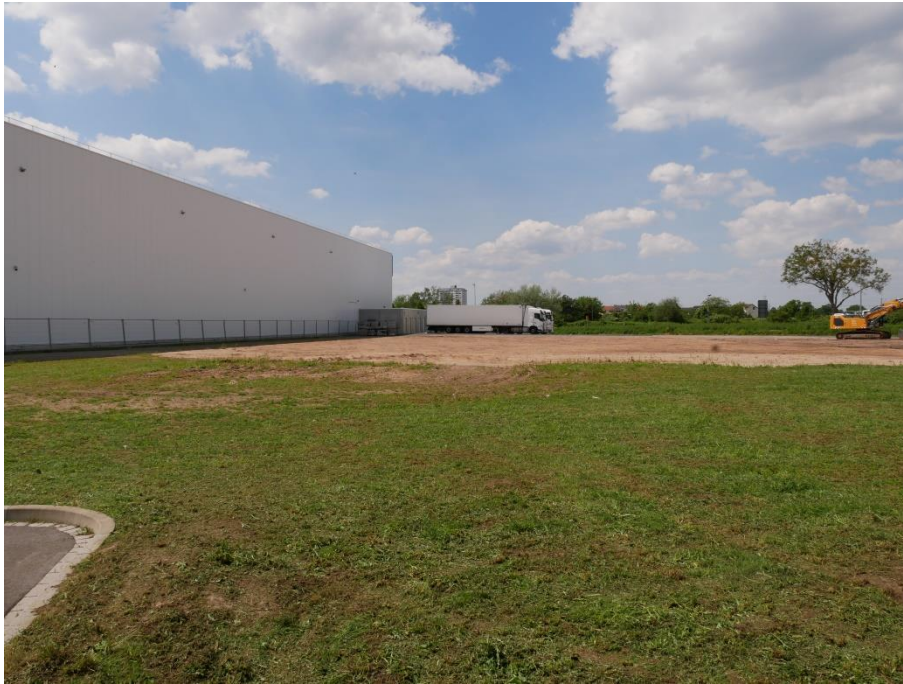
Abbildung 8: Zukünftige Baufläche mit frisch eingesäten Zierrasen und offenen Bodenflächen Mai 2024
