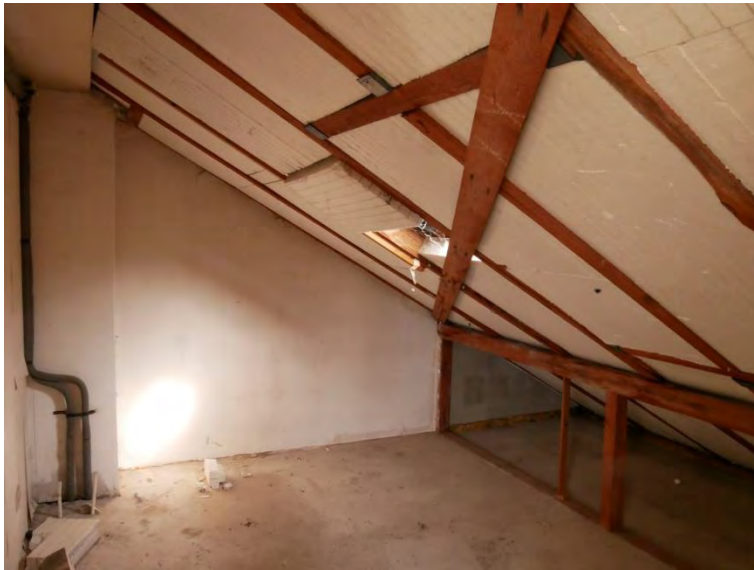
Abbildung 7: Dachstuhlkontrolle auf Kot, Fraßreste, Mumien
