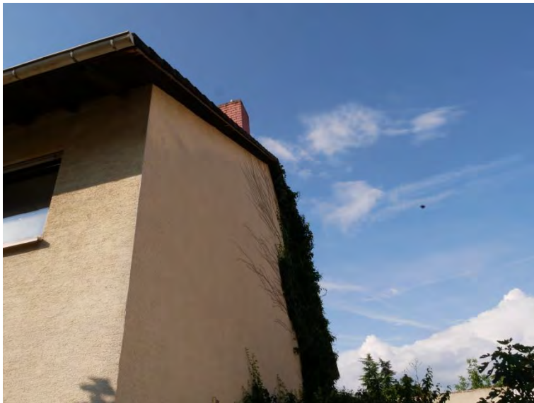
Abbildung 12: Kontrolle Fassade und Dachüberstände, Fensterbretter mit Fernglas
