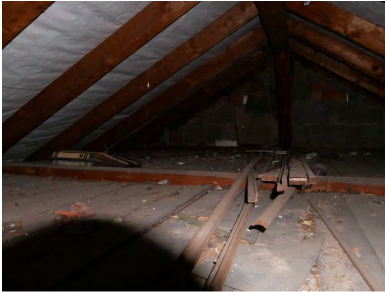
Abbildung 9: Dachstuhlkontrolle auf Kot, Fraßreste, Mumien
