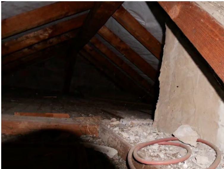
Abbildung 10: Dachstuhlkontrolle, Ausleuchtung mit Taschenlampe
