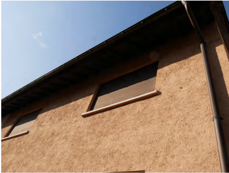
Abbildung 11: Kontrolle Fassade und Dachüberstände, Fensterbretter mit Fernglas
