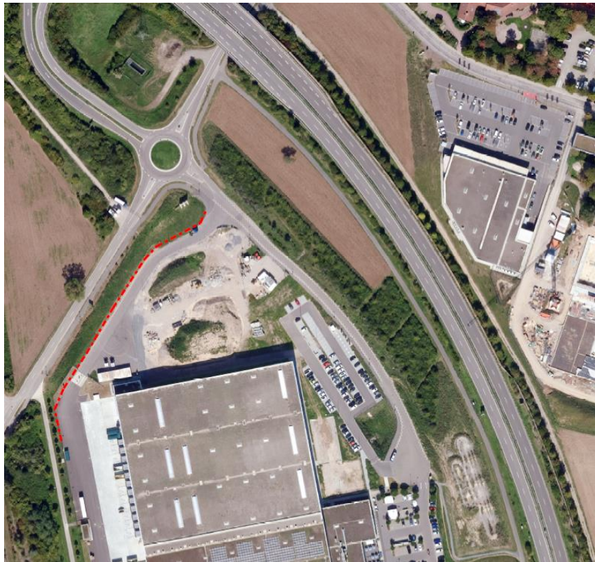
Abbildung 5: Reptilienzaun während dem Baubetrieb (rote Linie)
