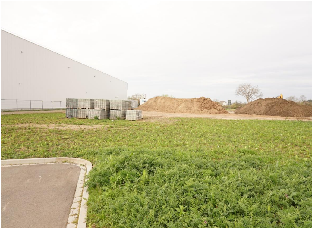
Abbildung 11: Oberbodenlager und Steinlager im März 2024
