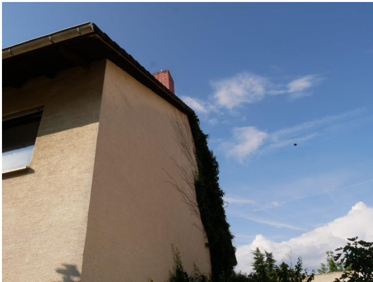
Abbildung 12: Kontrolle Fassade und Dachüberstände, Fensterbretter mit Fernglas
