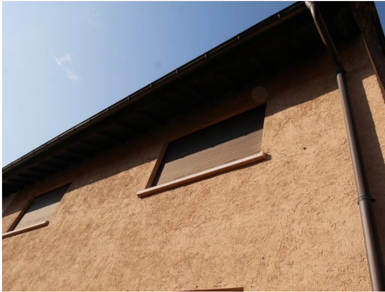
Abbildung 11: Kontrolle Fassade und Dachüberstände, Fensterbretter mit Fernglas
