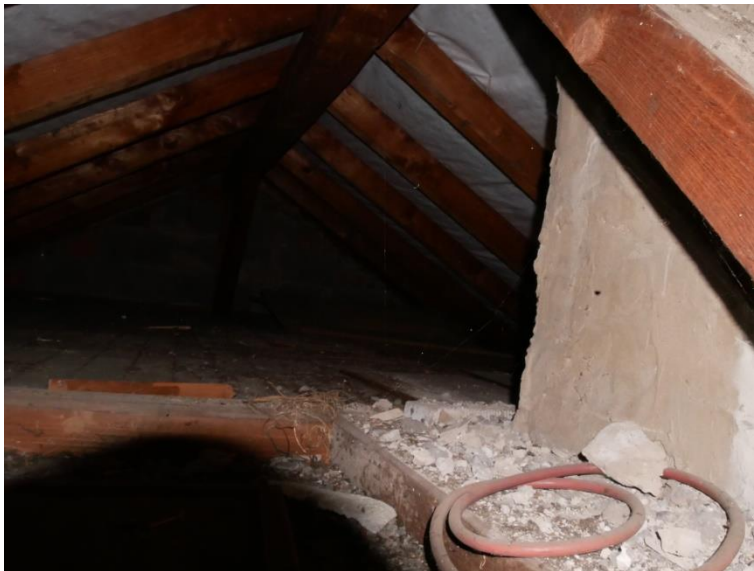
Abbildung 10: Dachstuhlkontrolle, Ausleuchtung mit Taschenlampe
