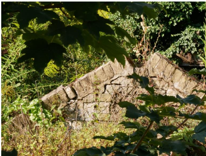
Abbildung 20: Reste Fundamente / Mauerwerk Gewächshäuser August 2024
