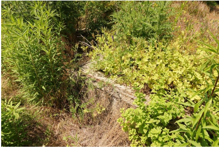
Abbildung 13: Sonnplätze Mauereidechsen an alten Gewächshausfundamenten Mai 2024
