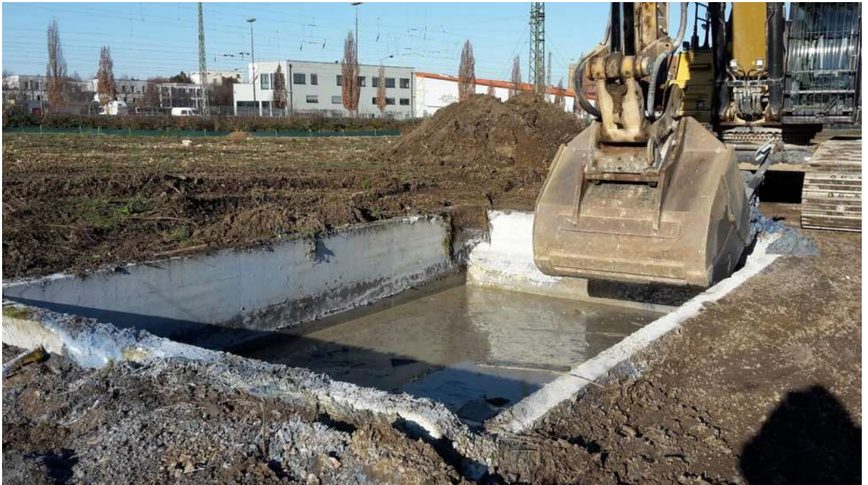
Blick auf das Absetzbecken. Schlamm ca. 0,5 m mächtig im Becken plus ca. 0,1 m überstehendes Wasser.
