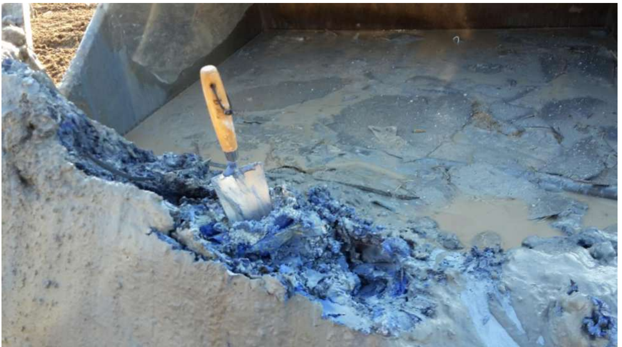
Blick in die Baggerschaufel, auf den Schlamm. Das überstehende Wasser war aufgrund von Minusgraden in der Außentemperatur an der Oberfläche gefroren.
