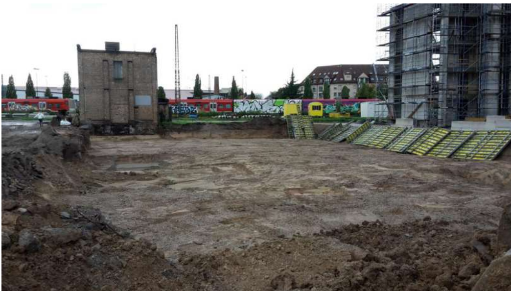
Abb. 4-1 Blick aus NW über die Baugrube nach Erreichen des Planums; li die Gebäude des 1. Bauabschnitts, im Hintergrund das ehem. Farben- und Lacklager (09.11.2022).
