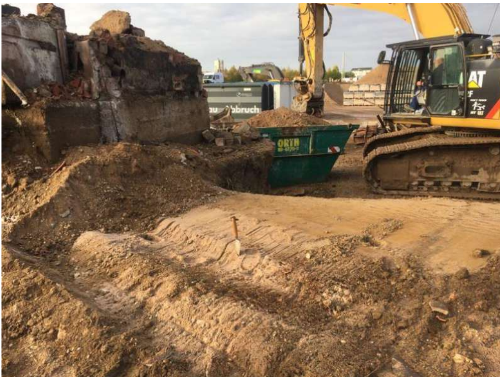
Abb. 3a + b Bereichsweise Sande und Kiese oder Schuff, frei von Bauschutt.
