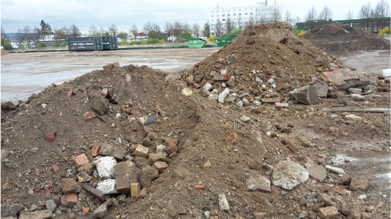
Abb.1 Blick auf das noch 2-teilige Haufwerk mit Auffüllungen aus den Bereich unterhalb des Aufspanntisches.
