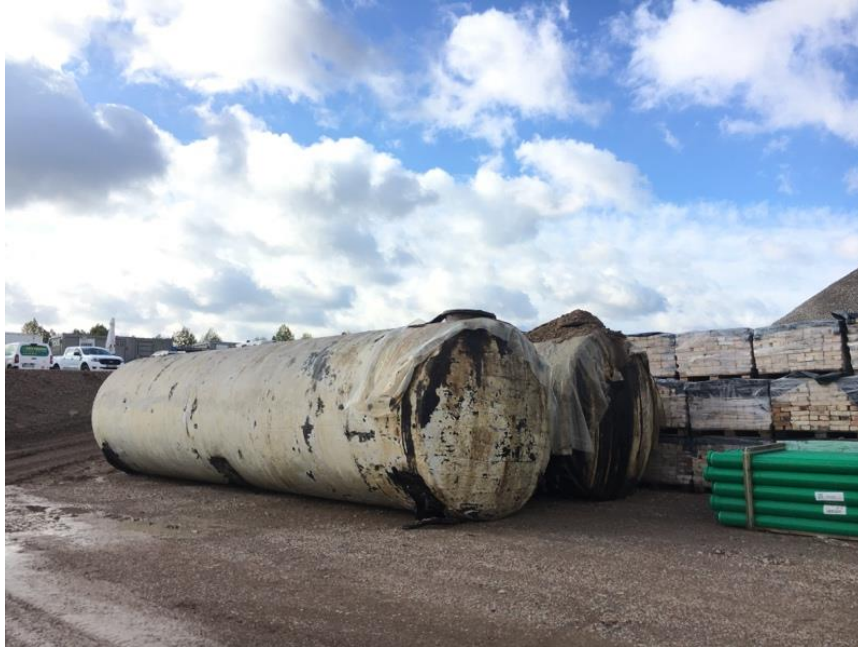
Abb. 2 Blick auf die beiden ausgebauten Heizöltanks.
