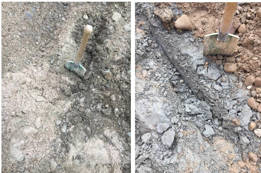
Abb. 5 Blick auf die geruchlich unauffällige Baugrubensohle mit grauen Füllsanden und -kiesen.
