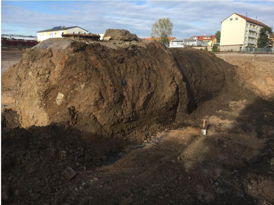
**Abb. 4-2 Blick auf den freigelegten Erdtank. Der Tank war seitlich in eine braune, schluffig-sandig-kiesige Auffüllung eingebettet, welche im Bereich des vorderen Domschachtes einen deutlichen MKW-Geruch zeigte. Die Entnahme der Bodenproben zur Beweissicherung erfolgte zu beiden Seiten, vor und, nach der Tank-Bergung, auch unterhalb des Tanks.**
