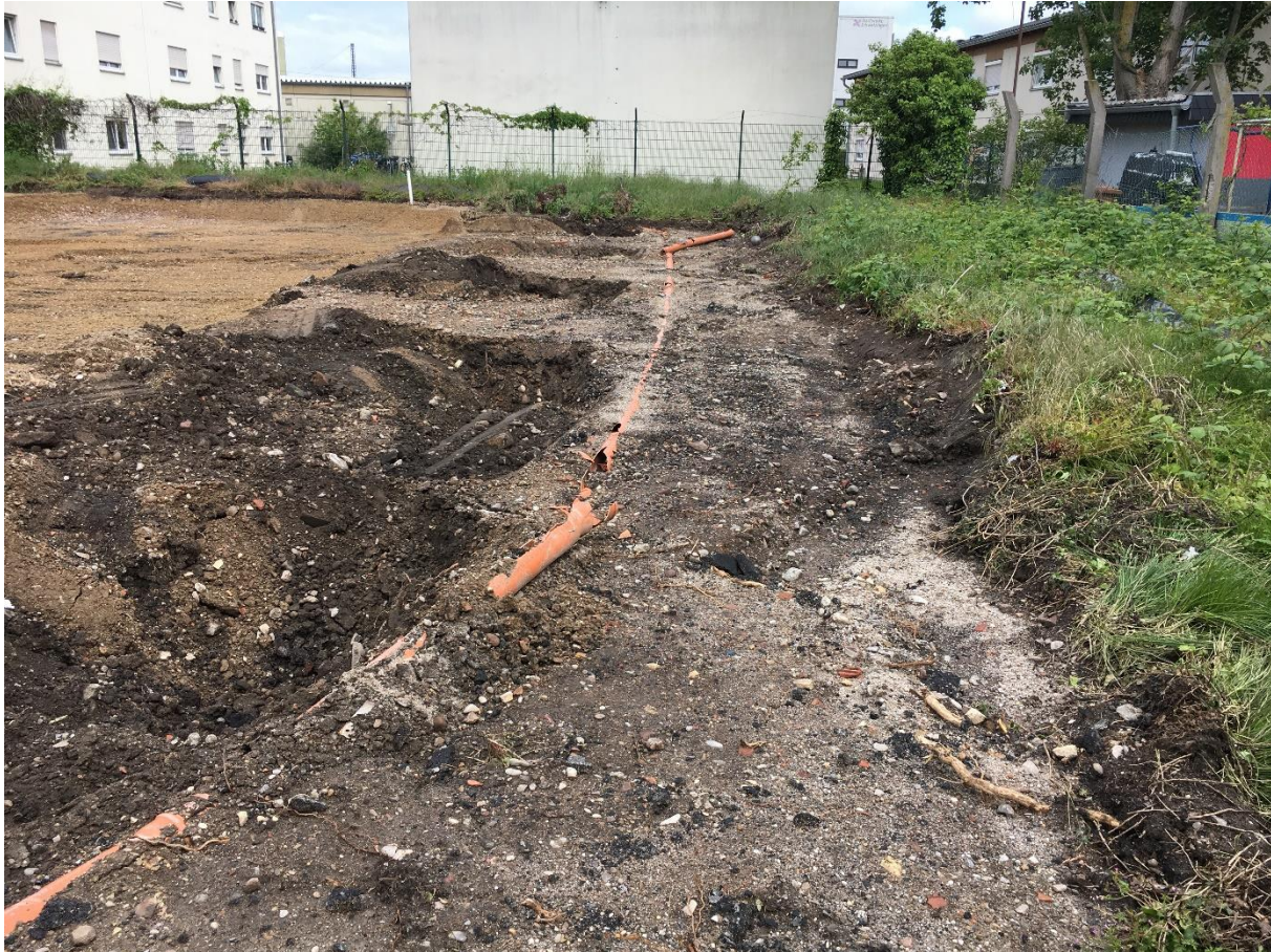
Abb. 4-2 Blick auf den Bereich an der nordöstlichen Grundstücksgrenze, Randbereich des Parkplatzes/ehemaliges Sägewerk: Brandschutt, nach Rückbau der Schwarzdecke und unterhalb der Schottertragschicht (gelbbraun) mit Abwasserleitungsrohren / Mischprobe MP 2
