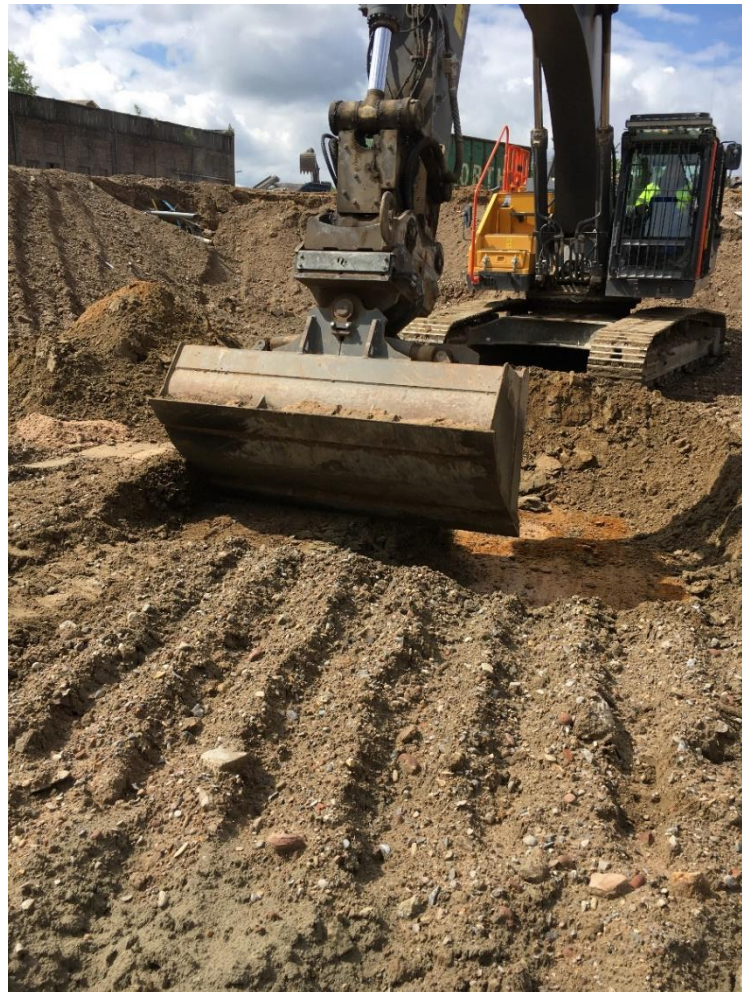
Abb. 4-2 Blick in die Baugrube des TB-Gebäudes
