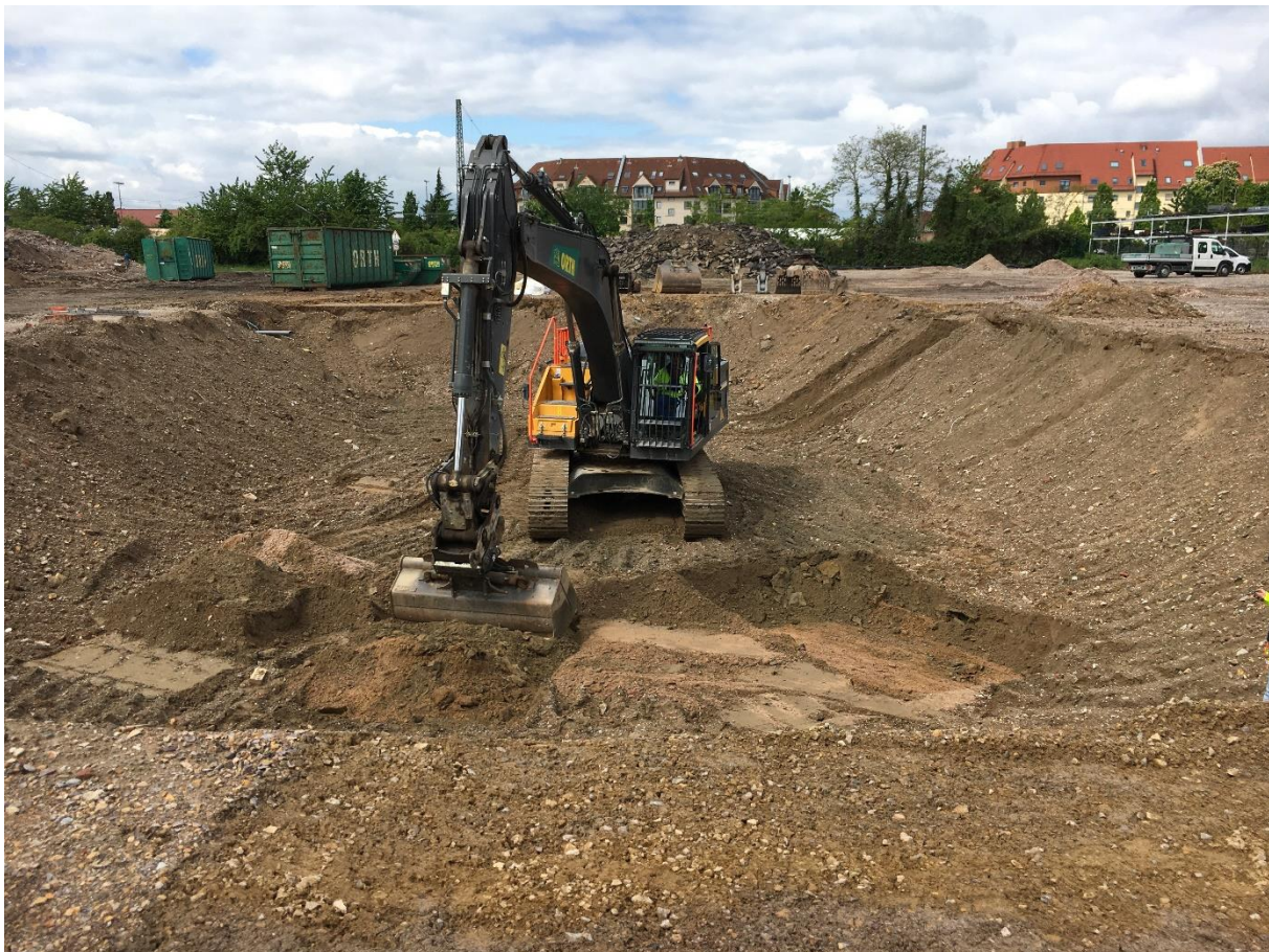
Abb. 4-1 Blick über die Baugrube nach Rückbau des Laborgebäudes
