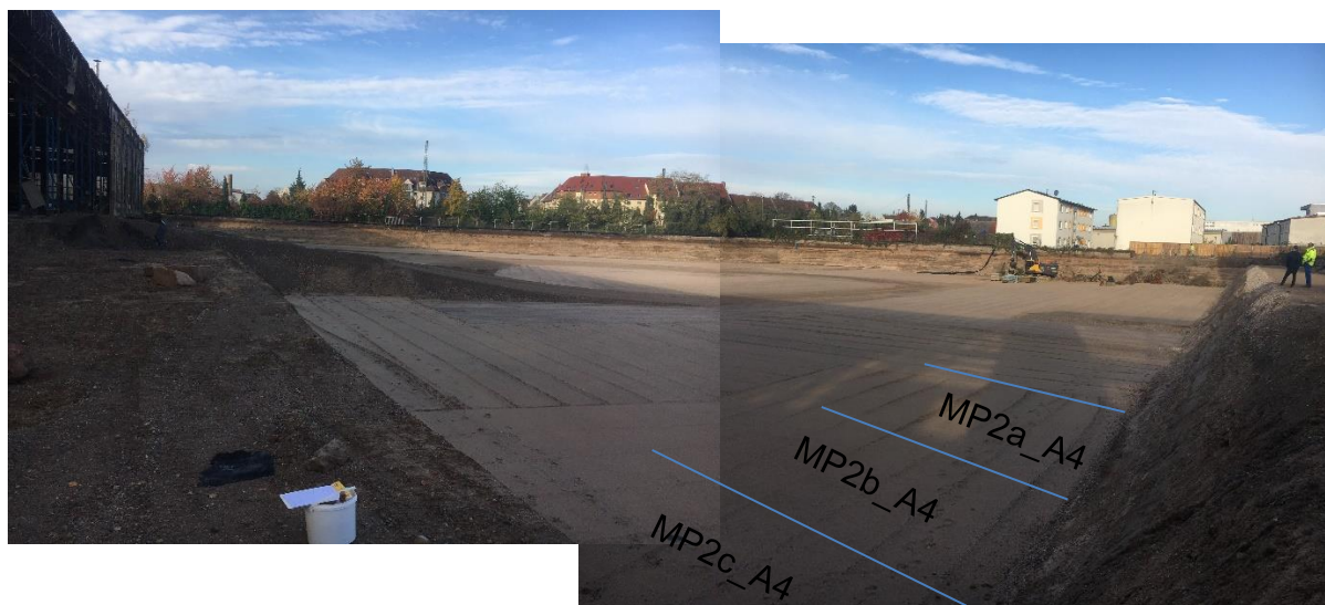
Abb. 4-3 Blick aus SO über die Baugrube nach Erreichen des Planums; im Vordergrund das tiefergelegte Feld A4 mit den nachbeprobten Teilbereichen. Stand 25.10.2021.
