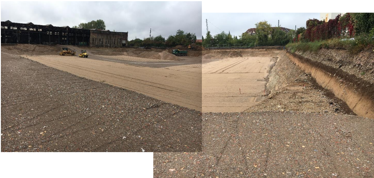
Abb. 4-2 Blick aus NO über die Baugrube nach Erreichen des Planums; im Hintergrund verläuft die Baustraße und es lagern noch Haufwerke zur Abfuhr. Stand 04.10.2021.
