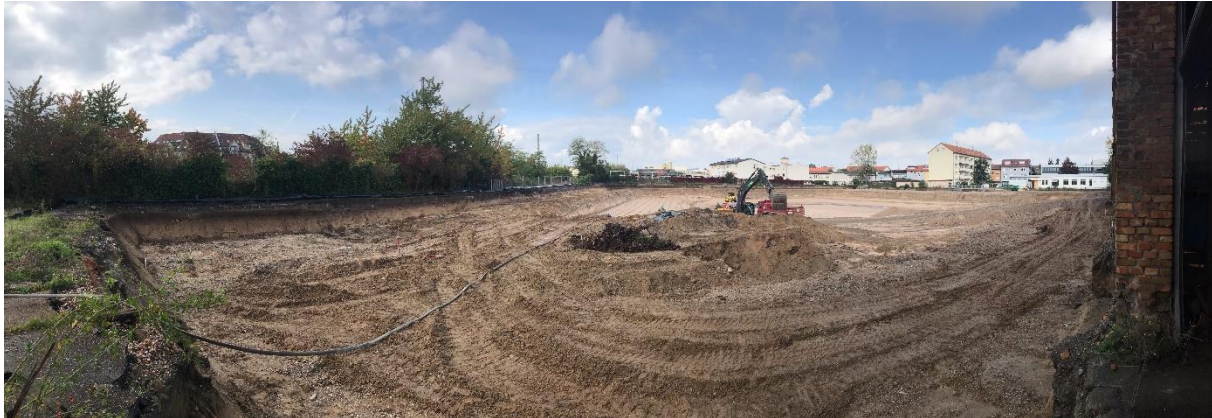
Abb. 4-1 Blick aus SW über die Baugrube nach Erreichen des Planums im Hintergrund. Im Vordergrund steht noch der Tank zum Ausbau (Quelle: CONCEPTPLAN). Stand 14.10.2021.
