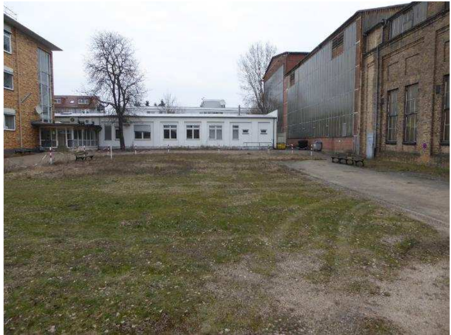
Foto 1 Blick nach Osten auf das Verwaltungsgebäude und die Produktions- halle (rechts)
