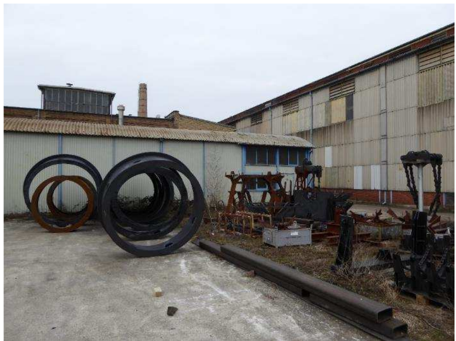
Foto 8 Die Produktionshallen sind teilweise mit Fassa- denverkleidungen ver- sehen.
