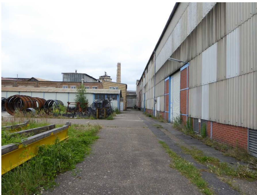
Foto 12: Fabrikgebäude und Lagerflächen
