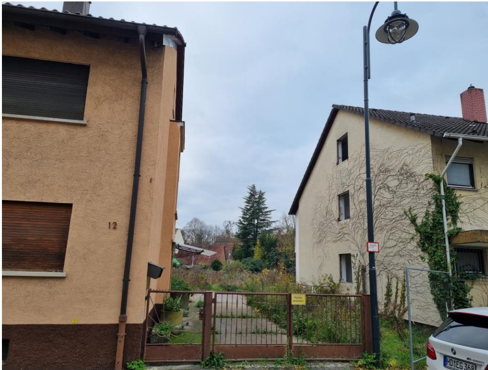
Bild 1: Die Spalten und Zugänge des Gebäudes könnten planungsrelevanten Fledermausarten potentiell als Quartiere dienen. Die Überprüfung erfolgte mittels Fernglas.
