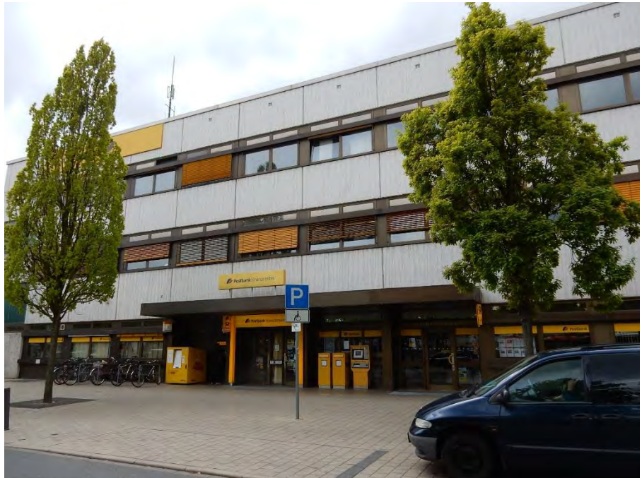
Foto 1 Frontseite des Gebäudes
