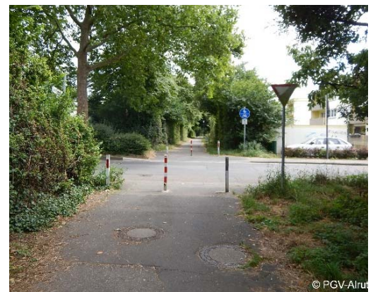
Abb. 6-29: Heinrich-Menger-Weg: Querung Schwalbenweg
