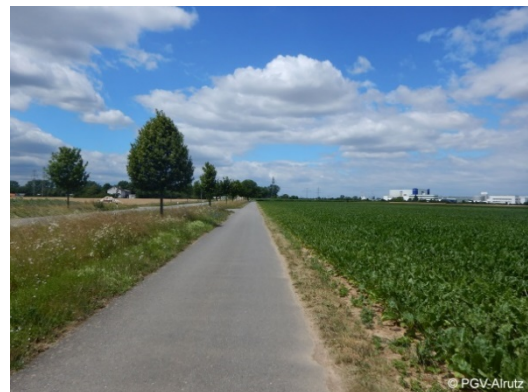
Abb. 6-16: Gemeinsamer Geh-/Radweg im Zweirichtungsverkehr am Stückerweg bis Höhe Autobahnbrücke
