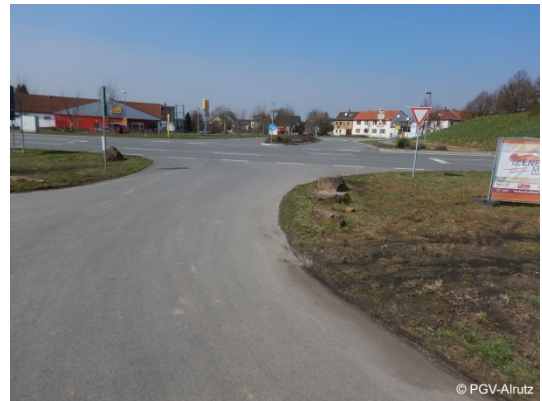
Abb. 6-12: Querung Oftersheimer Landstraße, Gemeinde Plankstadt
