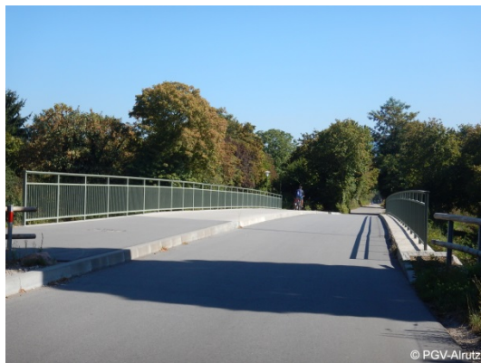
Abb. 6-33: Leonie-Wild-Straße: Höhe Brücke BAB A5
