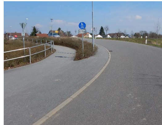
Abb. 6-43: Überquerung der Tunnelstrecke der B 535 in Richtung Plankstadt
