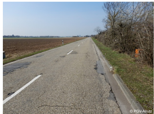
Abb. 6-8: Baumschulenweg, Stadt Heidelberg
