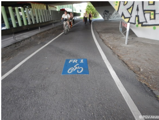
Abb. 7-14: Weiße Randmarkierung im Zuge einer Radvorrangroute in Freiburg
